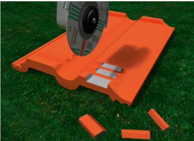
4 - Modification d'une tuile de toit
