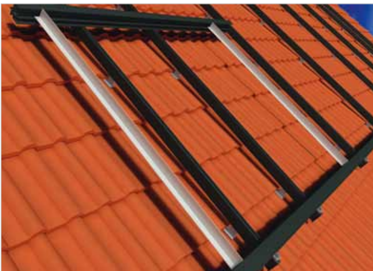
15a - Alignement d'un porte-module
